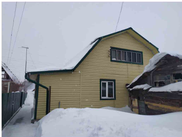
Фото 1. Фрагмент вида фасада.
