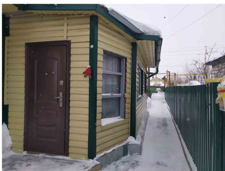
Фото 3. Фрагмент вида фасада.
