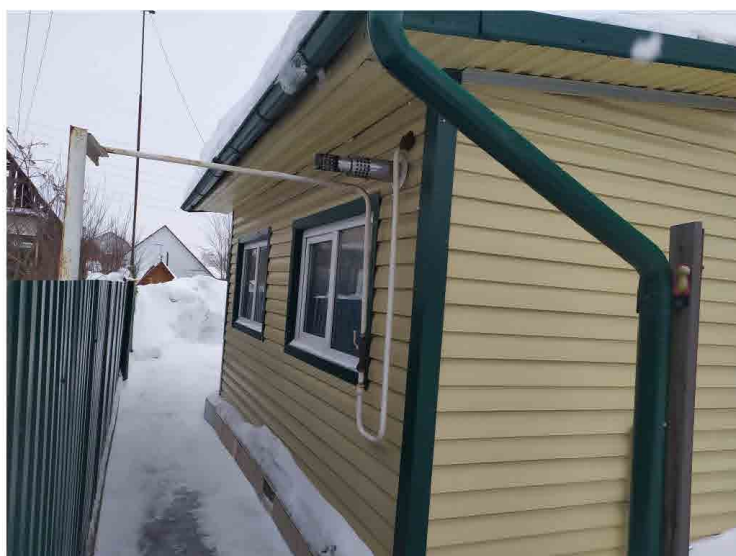
Фото 2. Фрагмент вида фасада.
