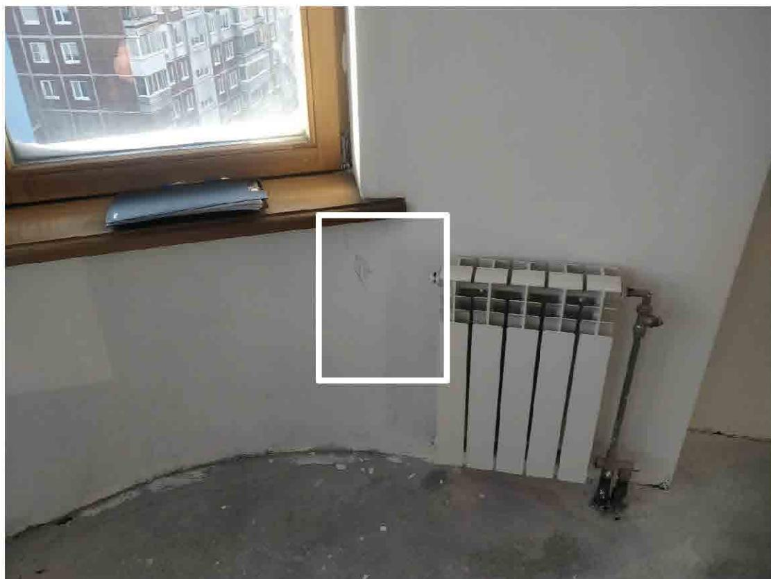
Фото 2. Трещина в стене, отслоение шпатлевки в области трещины
