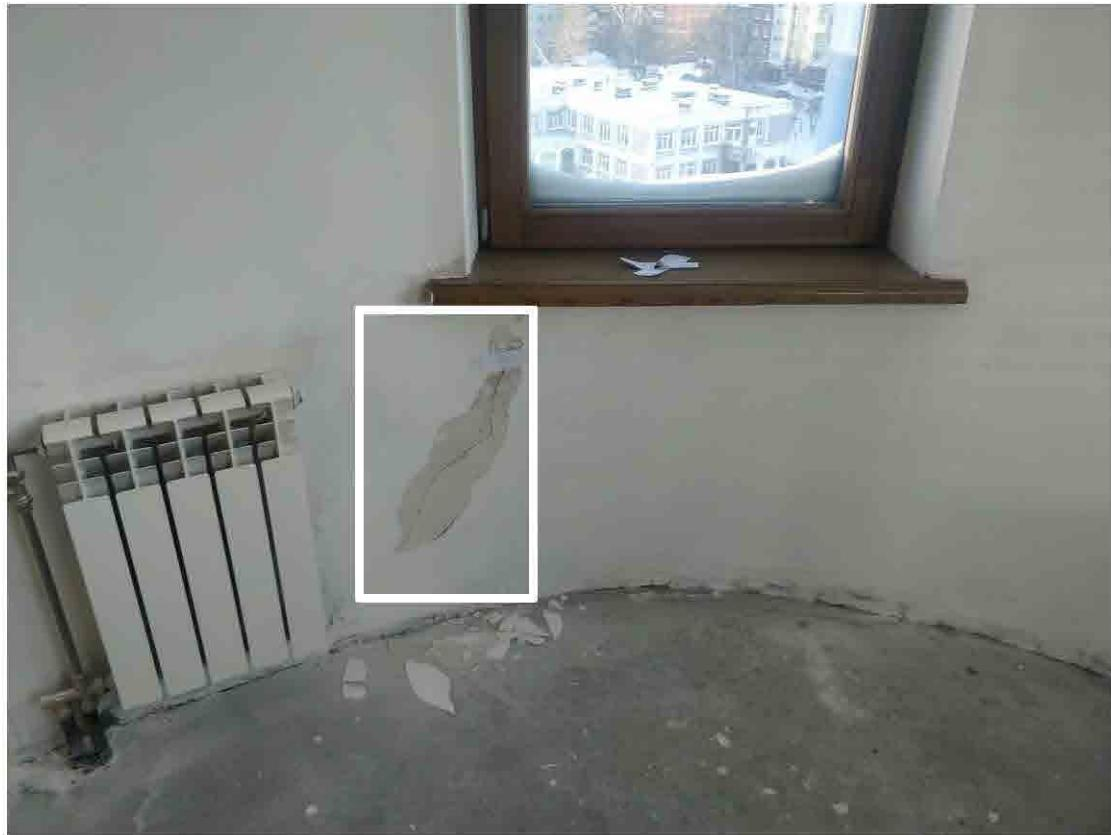
Фото 1. Трещина в стене, отслоение шпатлевки в области трещины
