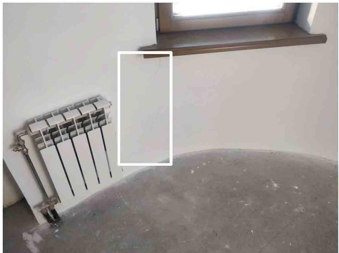
Фото 5. Трещина в стене, отслоение шпатлевки в области трещины
