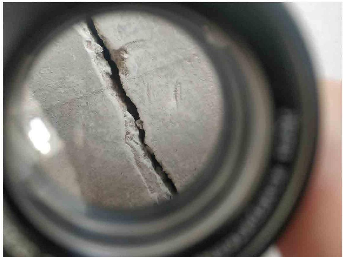
Фото 3. Ширина раскрытия трещины до 2 мм
