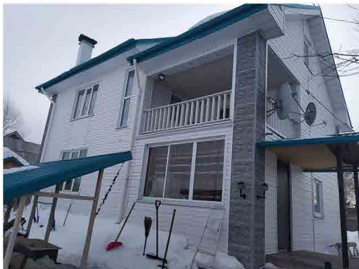
Фото 1. Фрагмент вида фасада.
