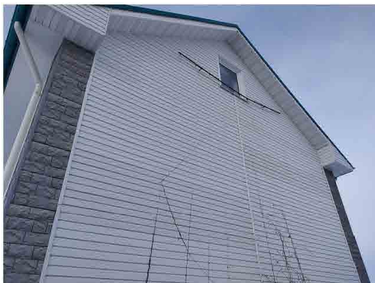
Фото 3. Фрагмент вида фасада.
