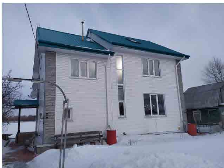
Фото 2. Фрагмент вида фасада.
