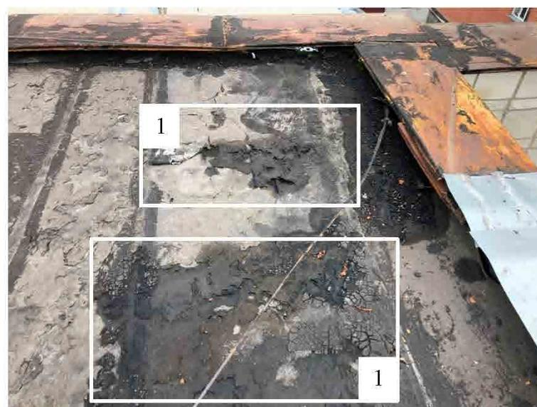
Фото 3. Фрагмент вида кровли. Дефекты: 1- разрушение кровельного покрытия
