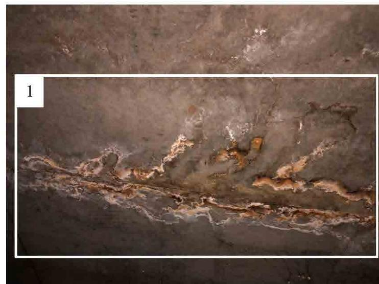
Фото 4. Фрагмент вида плиты покрытия. Дефекты: 1 – высолы, подтеки.
