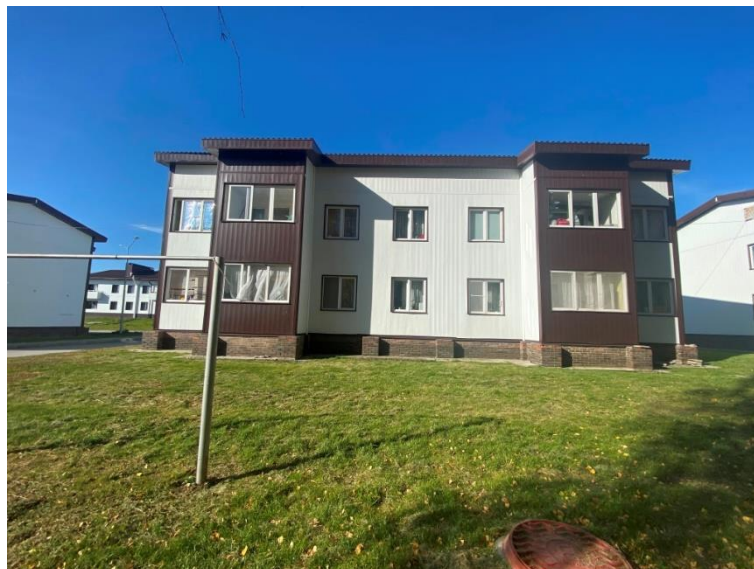
Фото №16. Фрагмент вида фасада.
