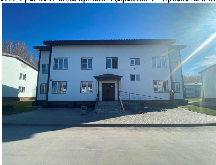
Фото №14. Фрагмент вида фасада.
