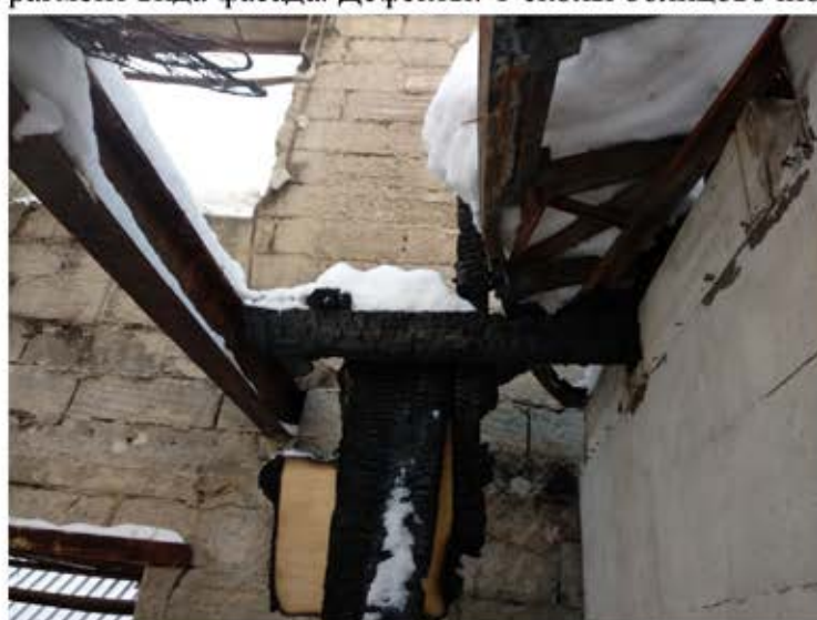
Фото 14. Фрагмент вида межэтажного перекрытия.
