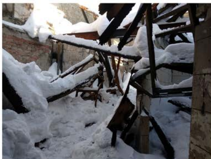
Фото 21. Фрагмент вида помещений.
