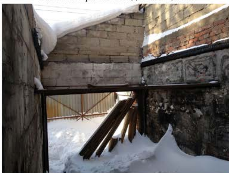
Фото 23. Фрагмент вида помещений.
