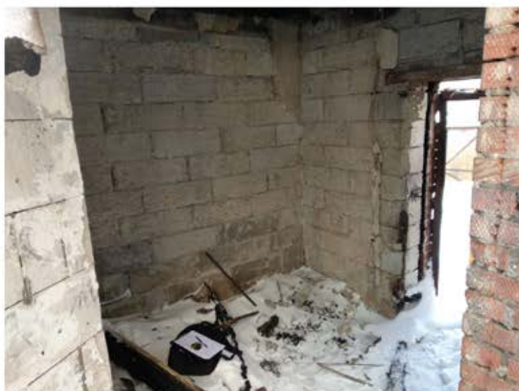
Фото 25. Фрагмент вида помещений.
