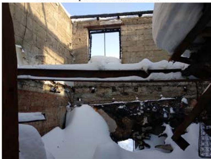
Фото 24. Фрагмент вида помещений.
