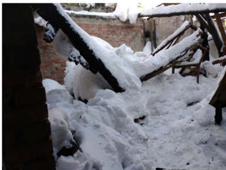
Фото 22. Фрагмент вида помещений.
