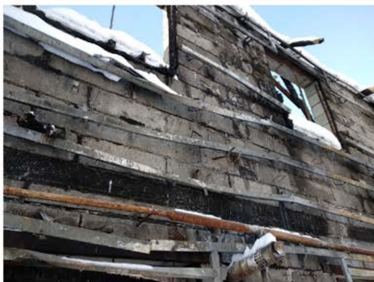
Фото 28. Фрагмент вида фасада.
