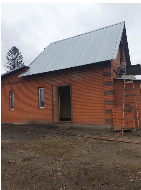
Фото 3. Фрагмент вида фасада.
