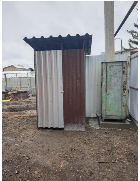
Фото 6. Фрагмент вида сооружения выгребной ямы.
