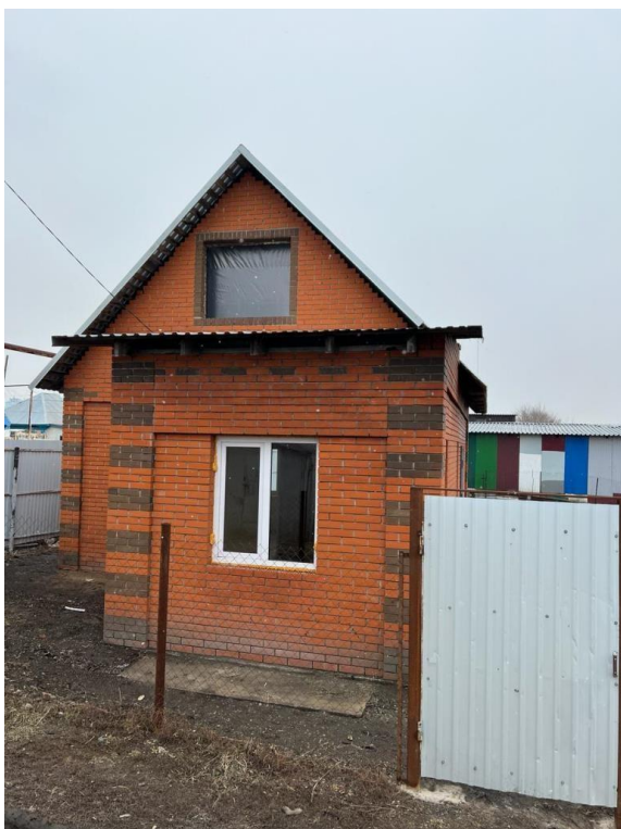
Фото 1. Фрагмент вида фасада.
