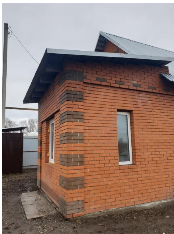
Фото 4. Фрагмент вида фасада.
