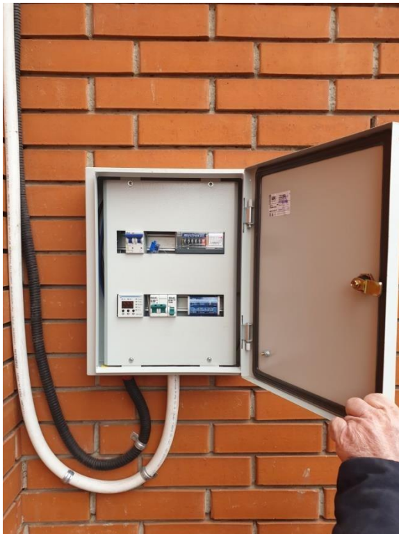
Фото 5. Фрагмент вида инженерных коммуникаций.
