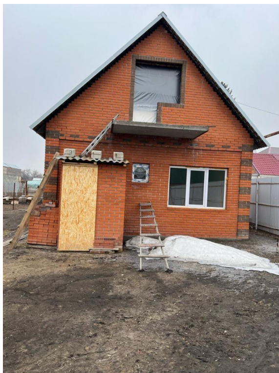
Фото 2. Фрагмент вида фасада.
