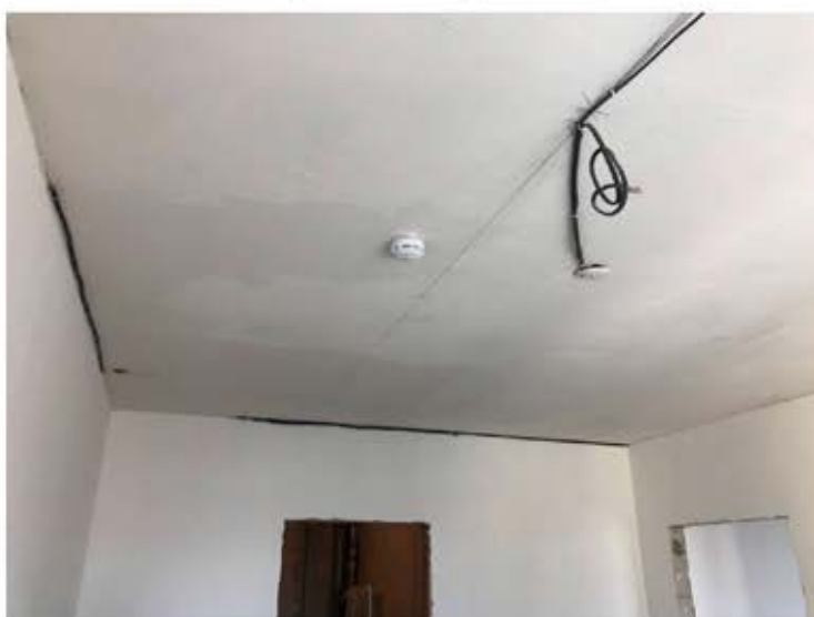
Фото 9. Фрагмент вида помещения.
