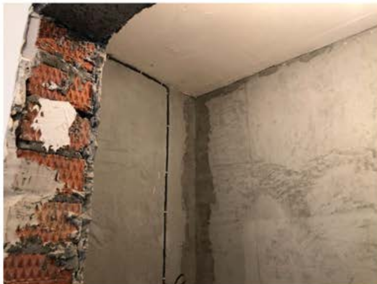
Фото 11. Фрагмент вида помещения.
