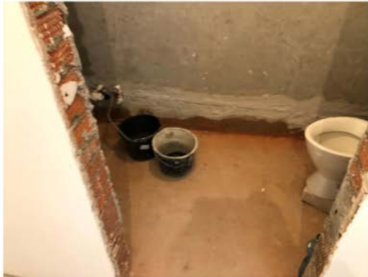
Фото 10. Фрагмент вида помещения.
