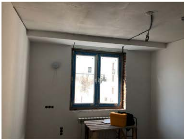
Фото 7. Фрагмент вида помещения.
