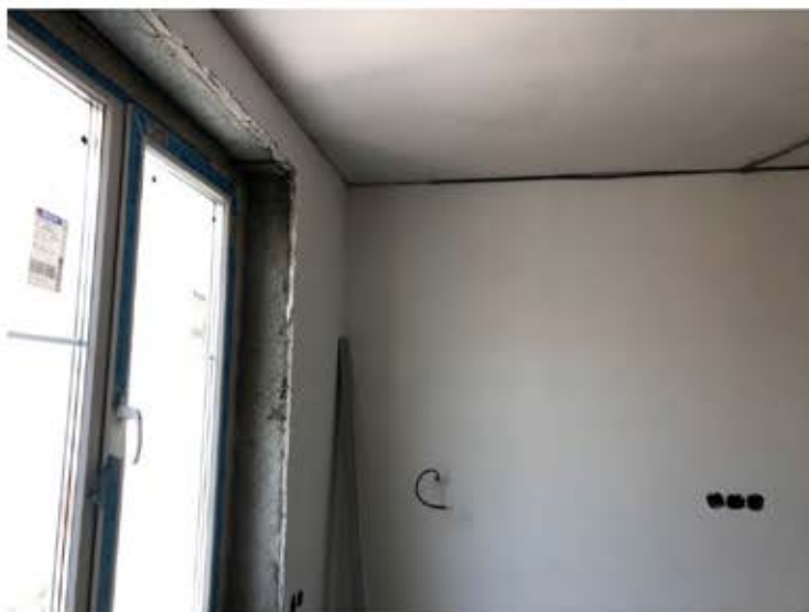
Фото 5. Фрагмент вида помещения.
