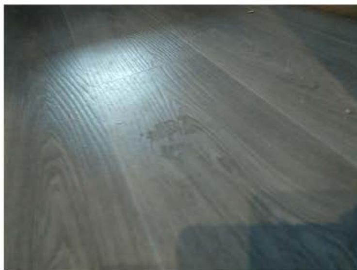
Фото 10. Загрязнение поверхности пола.
