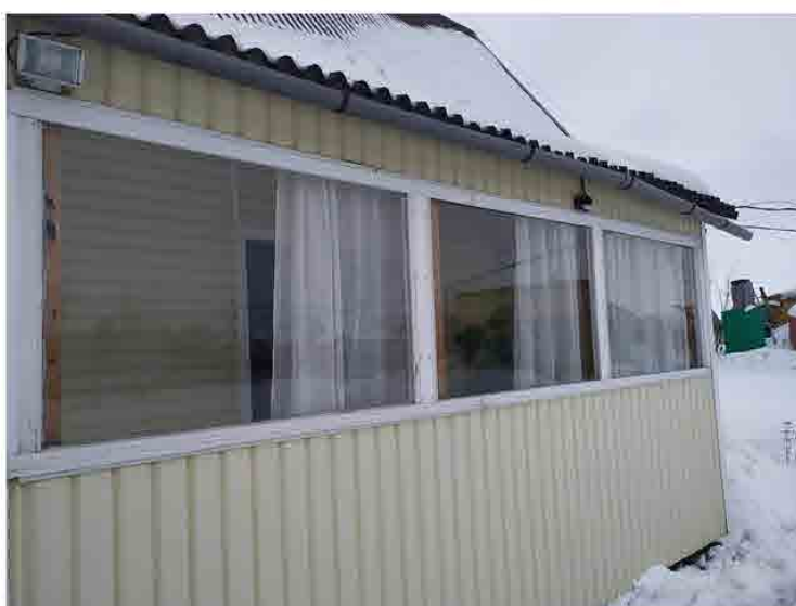
Фото 3. Фрагмент вида фасада.
