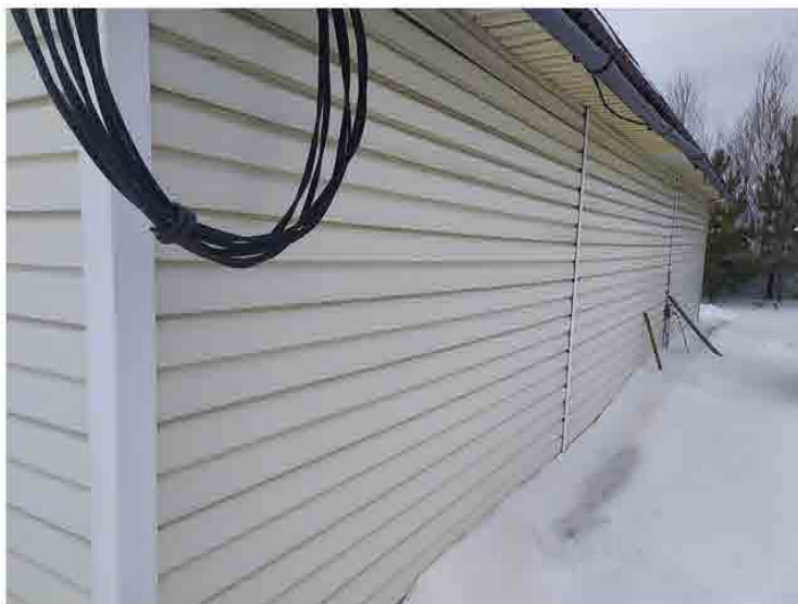
Фото 1. Фрагмент вида фасада.
