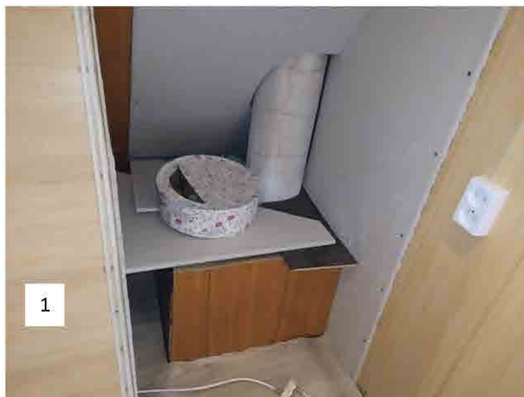
Фото 15. Фрагмент вида помещения.
