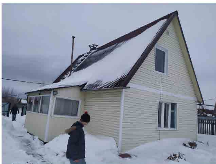
Фото 2. Фрагмент вида фасада.
