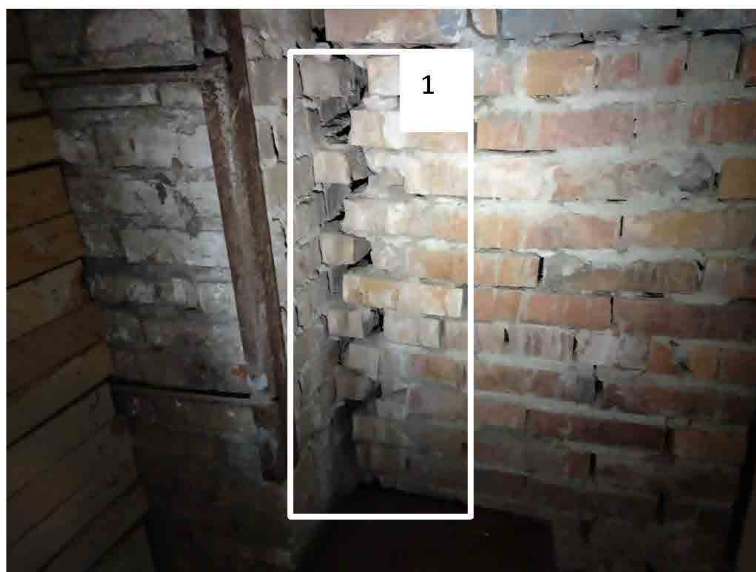
Фото 9. Дефекты: 1- сквозная трещина месте сопряжения стен
