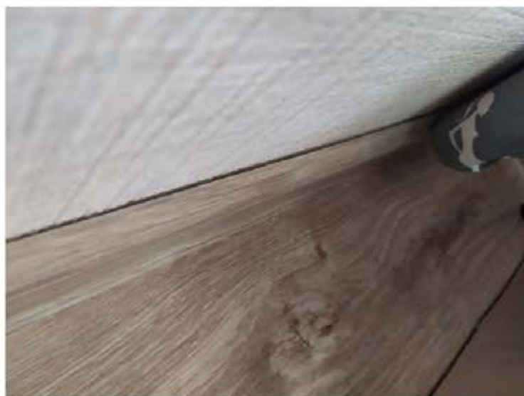
Фото 5. Вид стены. Дефекты: 1- зазор между плинтусом и стеной.
