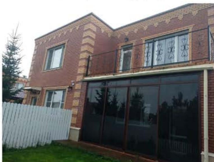
Фото 3. Фрагмент вида фасада.
