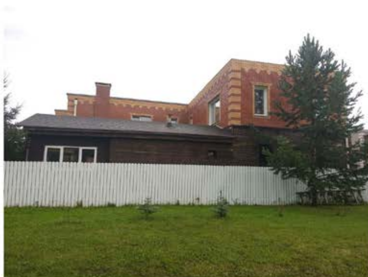
Фото 2. Фрагмент вида фасада.
