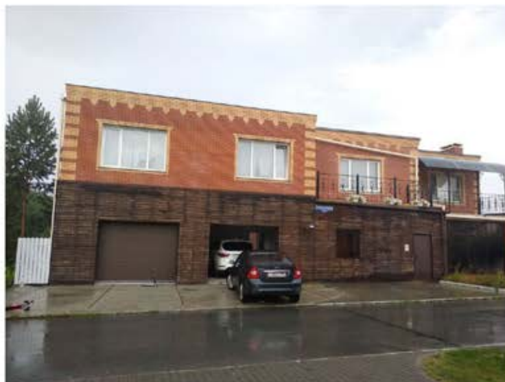
Фото 1. Фрагмент вида фасада.
